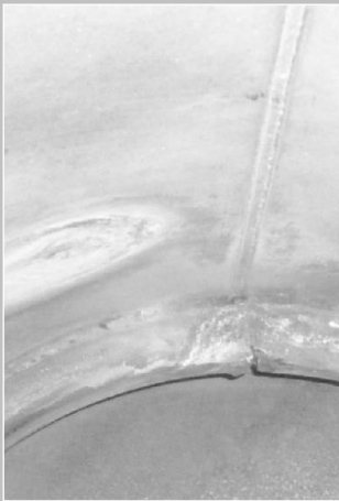
Surriscaldamento, cricca da corrosione
