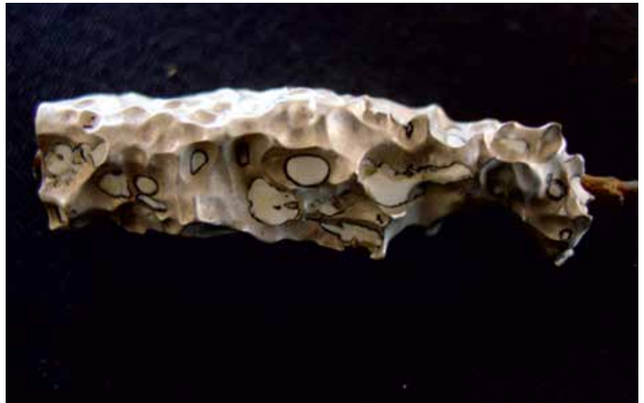
Halb verbrauchte Schutzanode
